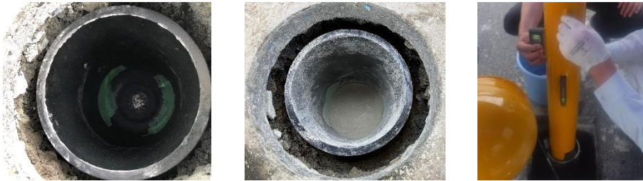
(ボラード設置状況)
