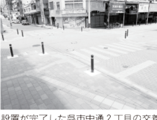
設置が完了した呉市中通2丁目の交差点
