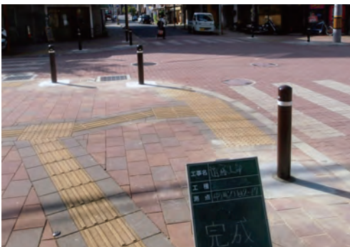
中通 工事完成確認
