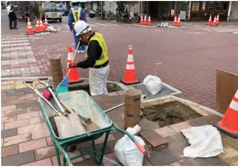
中通 工事風景
