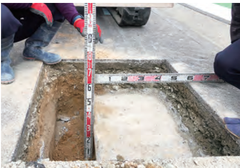
焼山本庄一丁目 埋設物確認
