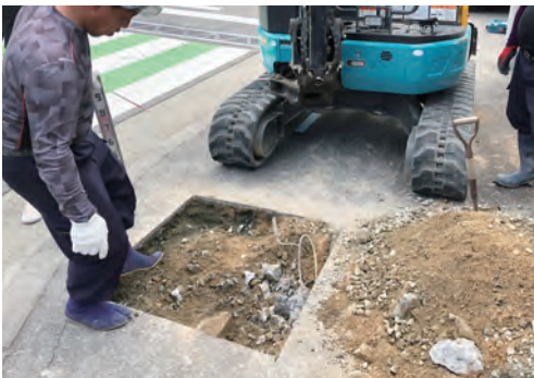
焼山本庄一丁目 工事風景
