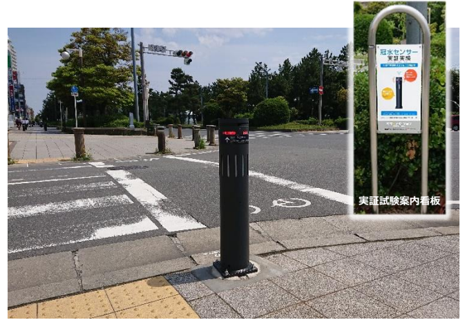
浦安市内に設置された冠水センサ付きポラード
